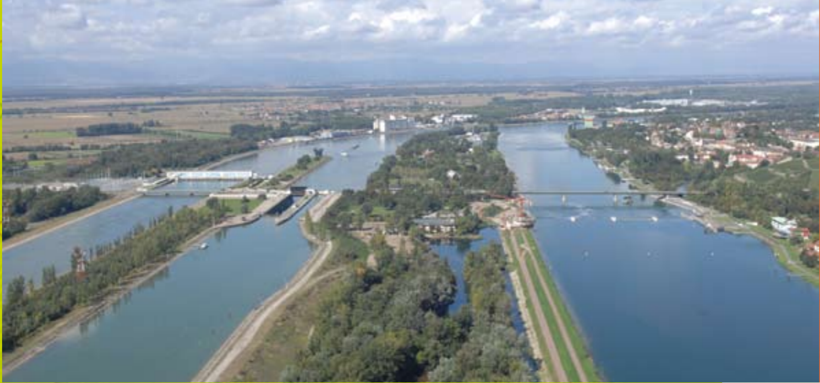
Pont sur le Rhin entre Vogelgrun et Breisach am Rhein (F/D) Rheinbrücke zwischen Breisach am Rhein und Vogelgrun (D/F)
