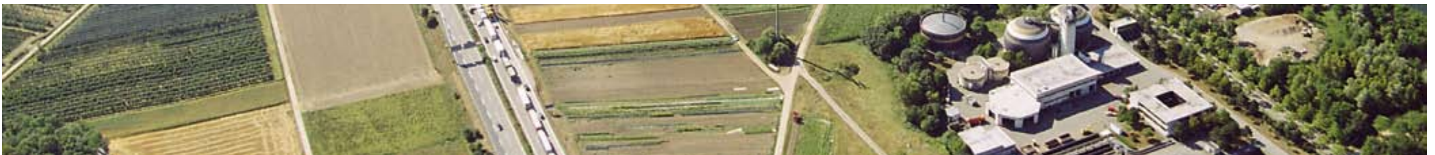
Autoroute A5 (D) Autobahn A5 (D)
